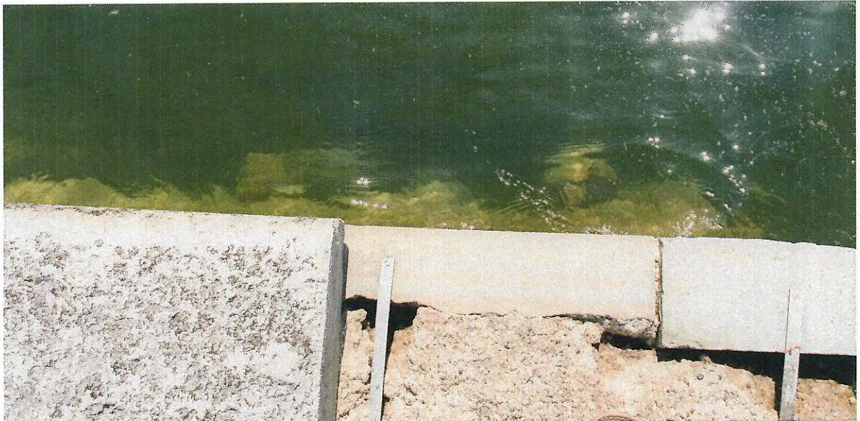
Lastplatsen. Stenkista mot väster som tryckts ut utanför bryggan. På 1970-talet kläddes den pågjutna betongplattan med den beklädnad av sågad kalksten på högkant. Som framgår av bilden hölls stenen på plats av rostfria kramlor.
