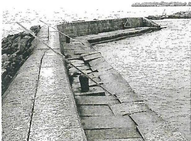
Parapeten, yttre armen.
