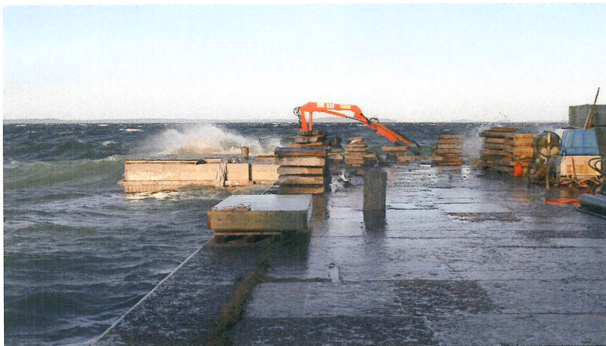
Utsatt läge. Pågående reparation.
